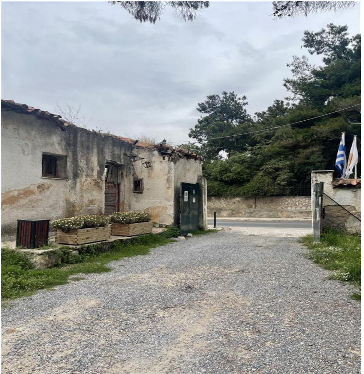
Εικόνα 1 Είσοδος επί της οδού Λ. Ηρακλείου
