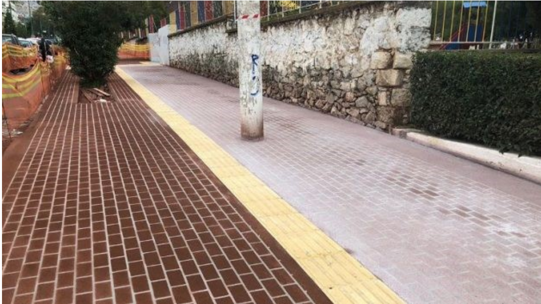
Εικόνα 2: Σταθερό, συνεχές και επιμελές αρμολόγημα (πηγή: https://www.michanikos-online.gr/ )
